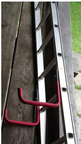
Matratzenlager 2. Obergeschoss, Fluchtweg über Fenster und Außen festangebrachte Leiter
